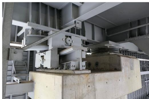
写真2 球面すべり支承の浮き上がり防止装置
