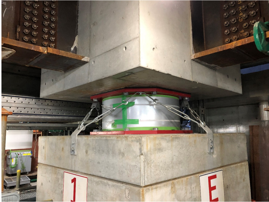
積層ゴム設置状況
